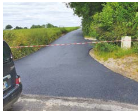
Réfection des voiries Impasse du Mouchy et Allée des Moniales
