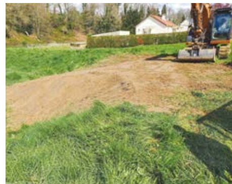
Création d'une rampe d'accès au bassin des scouts, route d'Epouville
