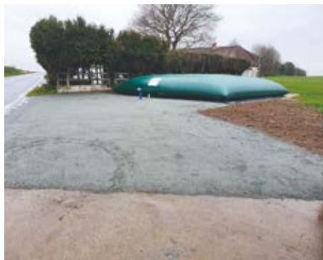
Installation d'une réserve incendie route de Sainneville
