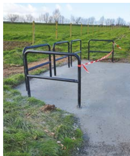
Aménagement d'un emplacement de stockage des poubelles, par la Communauté Urbaine
