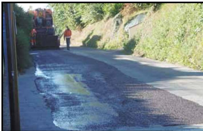
**Revêtement d'une partie de la route du calvaire d'un enrobé coulé à froid et d'un bi-couche gravillonné sur une partie de la route de Branmaze**
