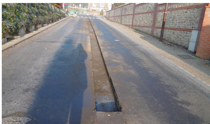
Remplacement du caniveau central rue des Anciens Combattants (2)
