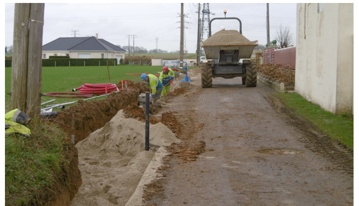
Travaux hameau des Mares (11)
