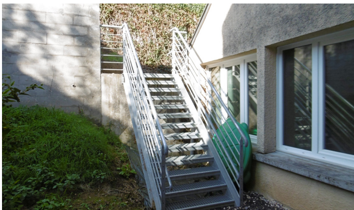
Escalier de secours de l'école maternelle (7)
