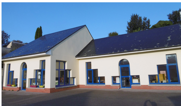
Rénovation de l'école maternelle (4)
