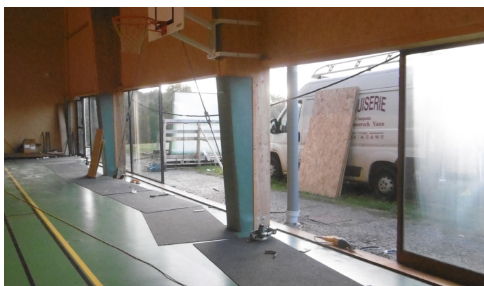
Changement des baies vitrées du gymnase (5)
